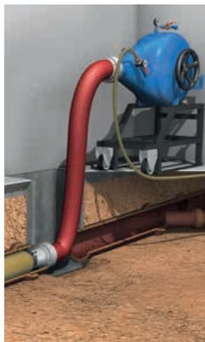
*Schlauchliner in geschlossener Bauweise*
