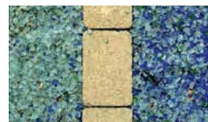
Wichtig ist eine wasserdurchlässige Deckschicht, damit das Niederschlagswasser ungehindert infiltrieren kann.
