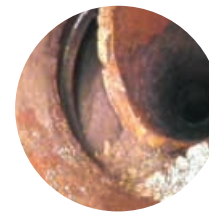
Verschobene Verbindung
