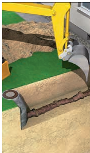
Erneuerung in offener Bauweise
